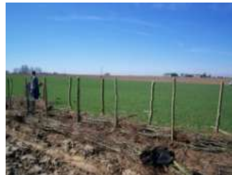
Tranchées réalisées pour la mise en place de fascines
